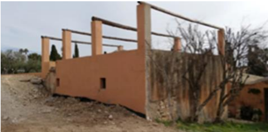
Construccions agrícoles Imatges diferents situacions
